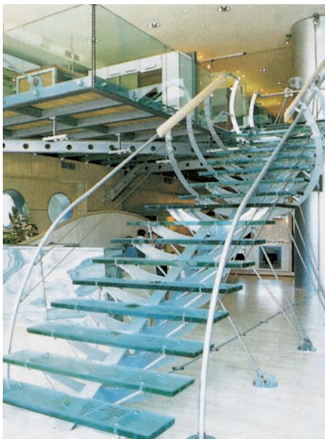
Εικόνα 9.24 Σκάλες με μεταλλικό φορέα και κρυστάλλινα πατήματα
