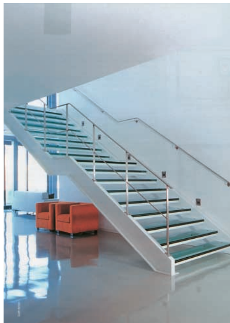
Εικόνα 9.24 Σκάλες με μεταλλικό φορέα και κρυστάλλινα πατήματα
