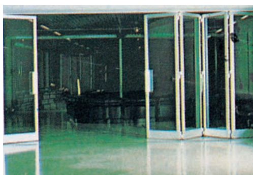
Εικόνα 10.35 Πτυσσόμενα φύλλα και λεπτομέρεια μεντεσέ
