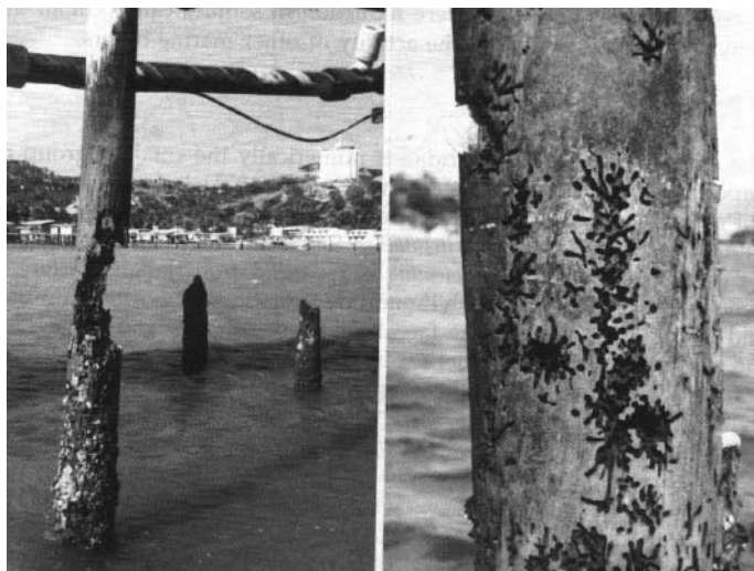
Εικ. 4.6 Εμφάνιση έντονης προσβολής ξύλου από θαλάσσιους οργανισμούς
