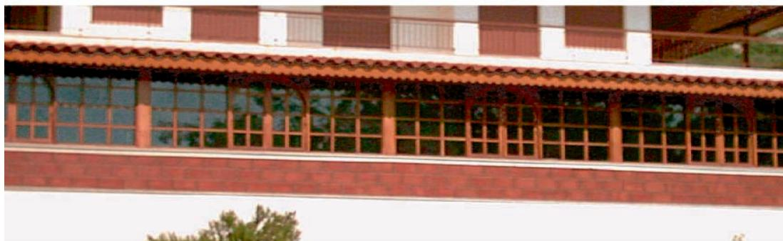
**Εικ. 4.52.** Κατασκευή υαλοστασίου με καϊτια.
