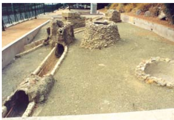
Τελική εικόνα συρών, αγωγού και υδραγωγείου.
