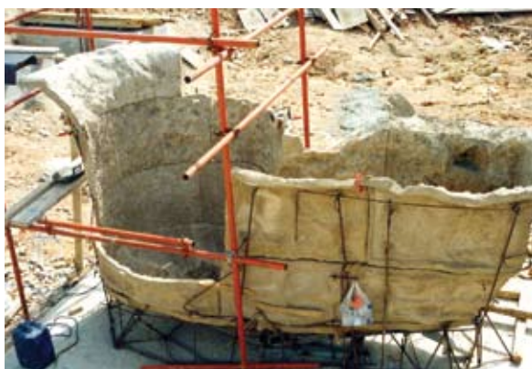
Διαδικασία κατασκευής του αντιγράφου του χυτηρίου.
