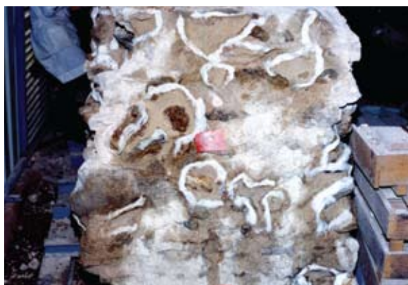
Διαδικασία στερέωσης της λιθοδομής του βαλανείου
