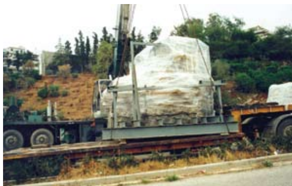
Διαδικασία μεταφοράς και τοποθέτησης τμήματος του υδραγωγείου.
