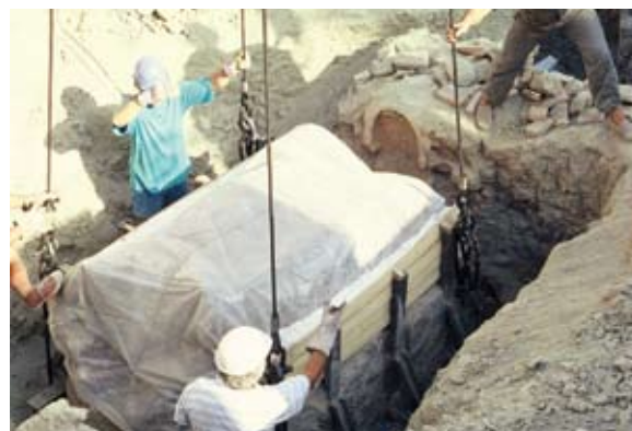
Απόσπαση τμήματος του υδραγωγείου.
