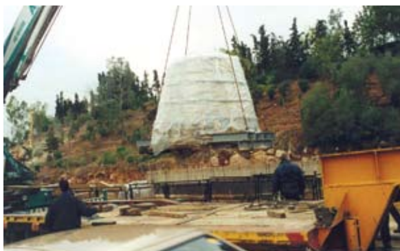
Διαδικασία μεταφοράς και τοποθέτησης του συρού.
