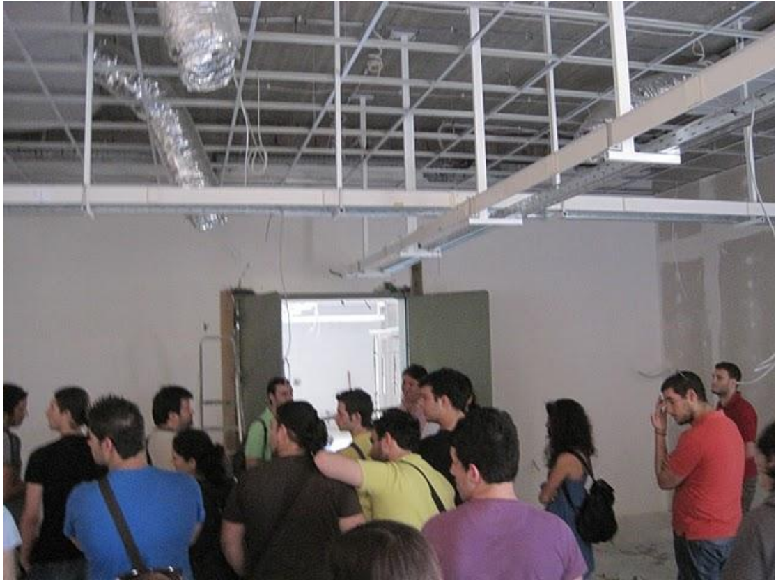
Νεο Εργαστήριο Laser, Ρεθυμνο
